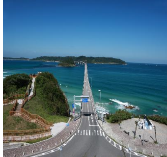
角島大橋(下関市)
