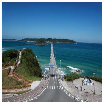
角島大橋(下関市)
