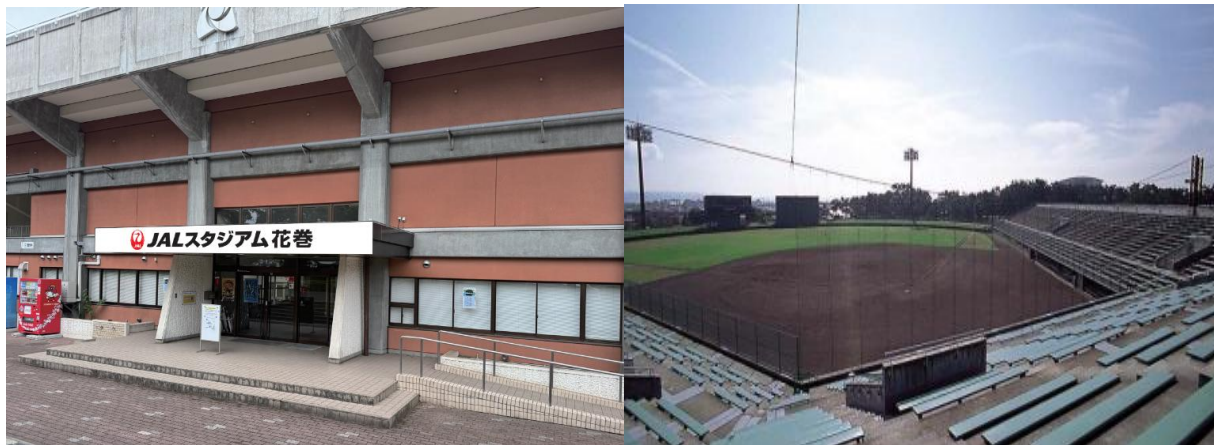
(写真左)エントランス、(写真右)花巻球場内
