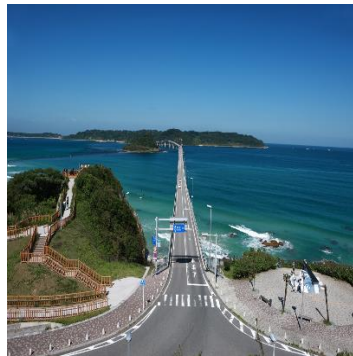
角島大橋 (下関市)
