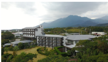
「屋久島グリーンホテル」外観
