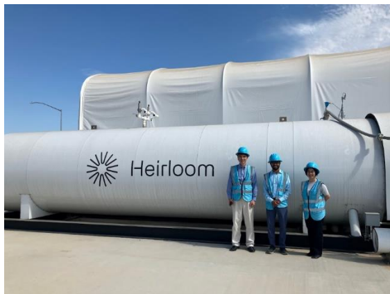
回収したCO 2 を貯蔵するタンク
