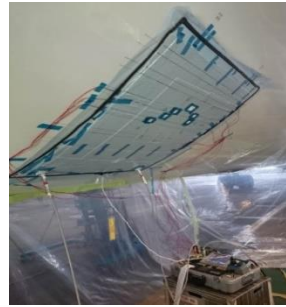
炭素繊維層を成形、温度検証をして接着する様子
