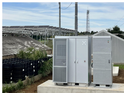
JAL Agriport農園「JAL FARM」に設置された蓄電池「PowerX Cube」
